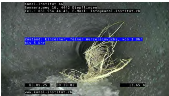
9, 00:02:10, 13.65m Einzelner, feiner Wurzeleinwuchs, von 3 Uhr bis 5 Uhr
