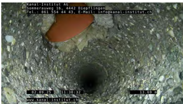
15, 00:07:57, 13.70m Anschluss eingespitzt, offen, bei 11 Uhr
