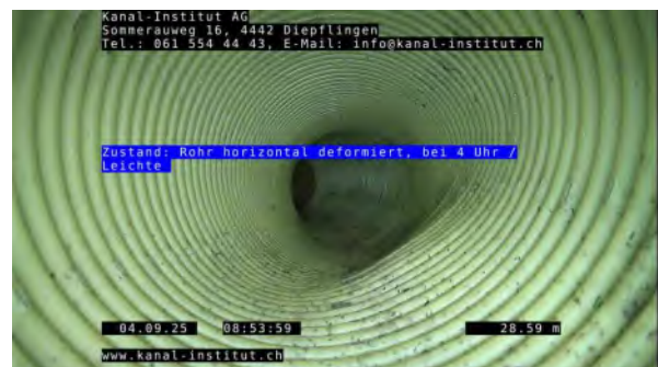
18, 00:02:20, 28.60m Rohr horizontal deformiert, bei 4 Uhr / Leichte
