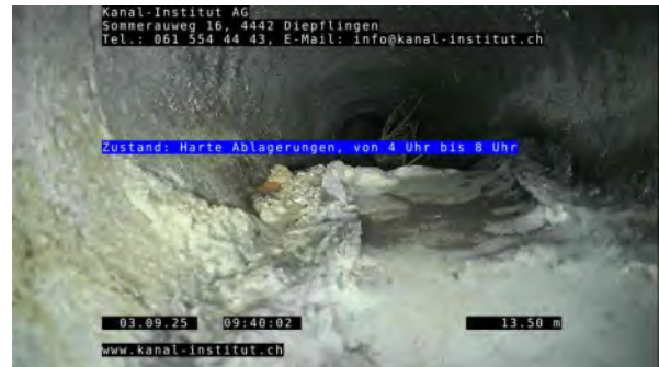
8, 00:02:36, 13.50m Harte Ablagerungen, von 4 Uhr bis 8 Uhr
