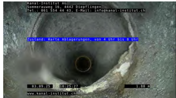
2, 00:00:39, 1.80m Harte Ablagerungen, von 4 Uhr bis 8 Uhr
