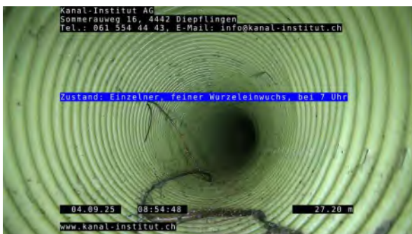
17, 00:02:53, 27.20m Einzelner, feiner Wurzeleinwuchs, bei 7 Uhr
