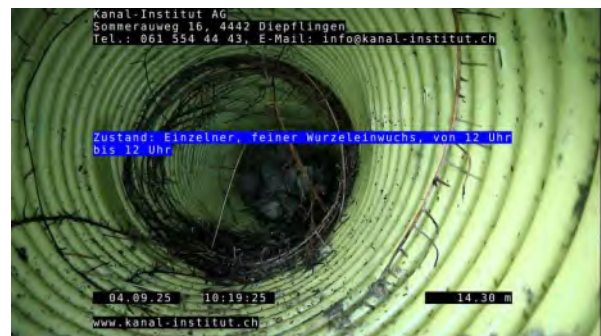
10, 00:00:29, 14.30m Einzeln, feiner Wurzeleinwuchs, von 12 Uhr bis 12 Uhr
