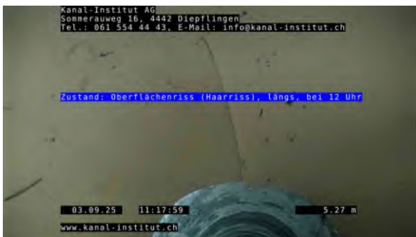
3, 00:01:39, 5.25m Oberflächenriss (Haarriss), längs, bei 12 Uhr
