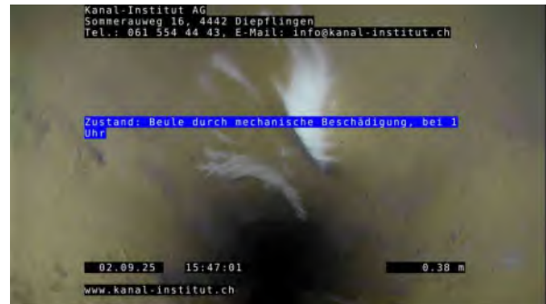
2, 00:00:44, 0.40m Beule durch mechanische Beschädigung, bei 1 Uhr
