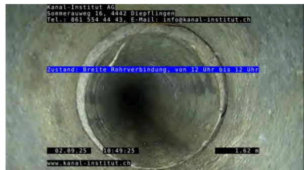
4, 00:01:28, 1.60m Breite Rohrverbindung, von 12 Uhr bis 12 Uhr
