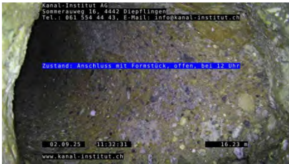
19, 00:09:35, 16.25m Anschluss mit Formstück, offen, bei 12 Uhr
