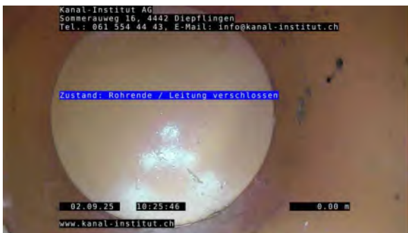
3, 00:00:08, 2.85m Rohrende / Leitung verschlossen
