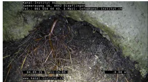
2, 00:00:07, 0.00m Rohranfang / Komplet verschlossen Wurzeleinwuchs
