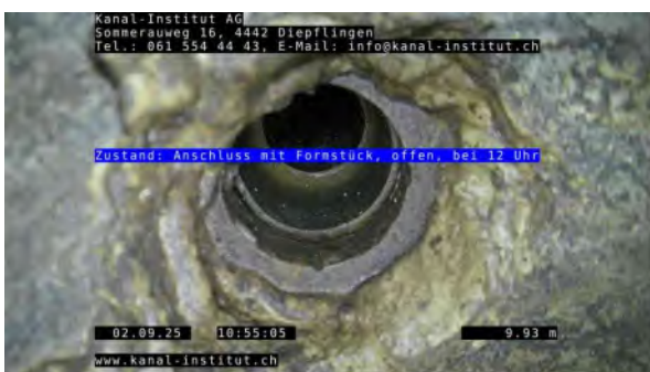
11, 00:05:52, 9.95m Anschluss mit Formstück, offen, bei 12 Uhr
