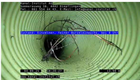
9, 00:00:59, 13.90m Einzeln, feiner Wurzeleinwuchs, bei 8 Uhr
