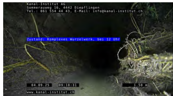
4, 00:02:49, 1.50m Komplexes Wurzelwerk, bei 12 Uhr
