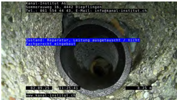
7, 00:04:36, 8.25m Reparatur, Leitung ausgetauscht / nicht Fachgerecht eingebaut
