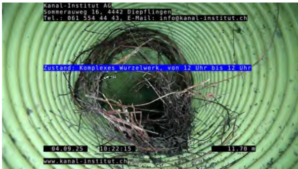
7, 00:02:09, 11.70m Komplexes Wurzelwerk, von 12 Uhr bis 12 Uhr
