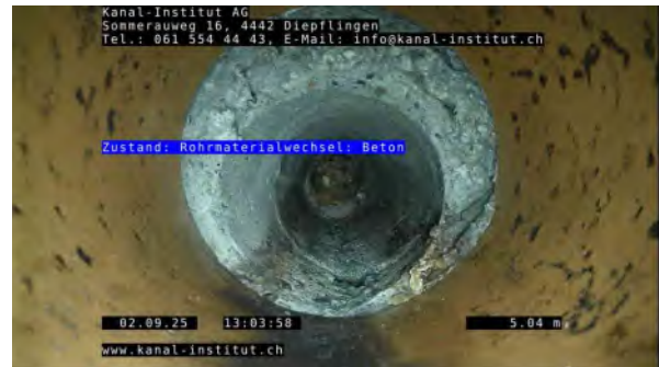
2, 00:01:12, 5.05m Rohrmaterialwechsel: Beton
