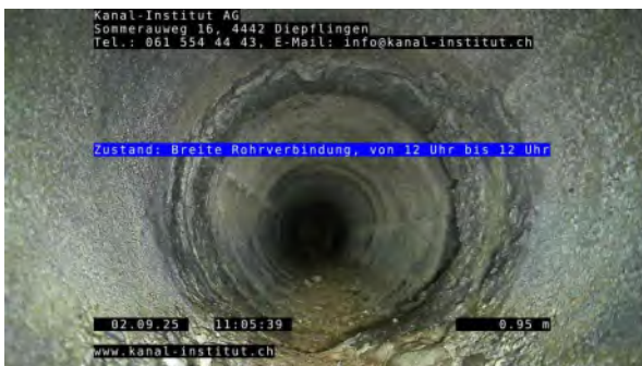
3, 00:01:28, 0.95m Breite Rohrverbindung, von 12 Uhr bis 12 Uhr
