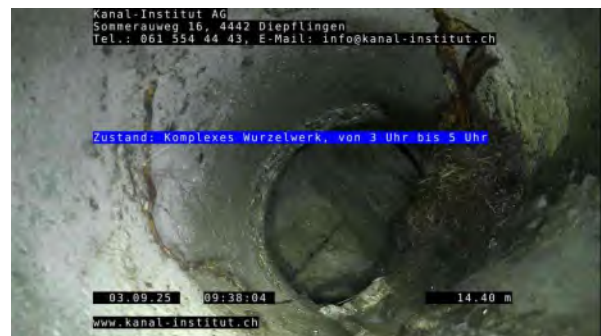
10, 00:01:39, 14.40m Komplexes Wurzelwerk, von 3 Uhr bis 5 Uhr
