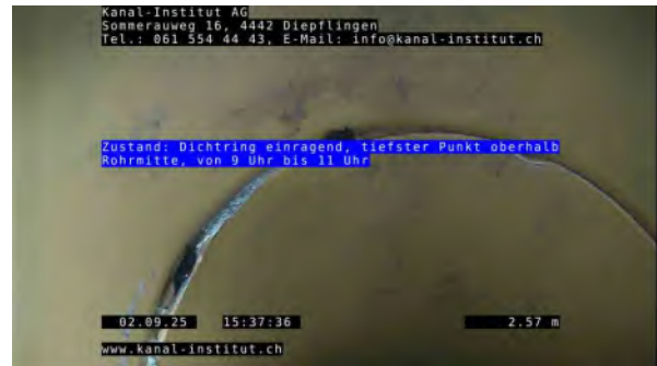
2, 00:01:23, 2.55m Dichtring einragend, tieftster Punkt oberhalb Rohrmittle, von 9 Uhr bis 11 Uhr
