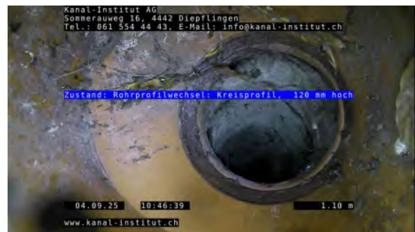
4, 00:03:30, 1.10m Rohrprofilwechsel: Kreisprofil, 120 mm hoch
