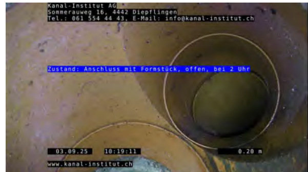
2, 00:04:49, 0.20m Anschluss mit Formstück, offen, bei 2 Uhr
