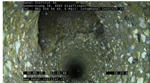
20, 00:09:35, 16.25m Anschluss mit Formstück, offen, bei 12 Uhr
