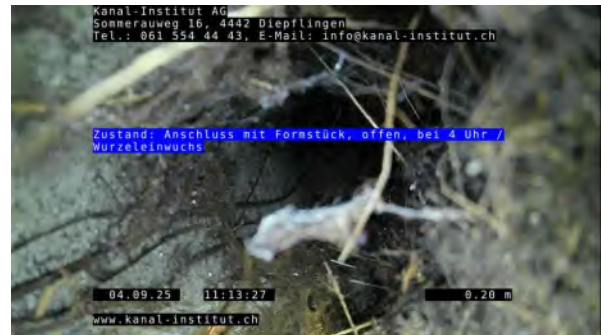
2, 00:06:00, 0.20m Anschluss mit Formstück, offen, bei 4 Uhr / Wurzeleinwuchs
