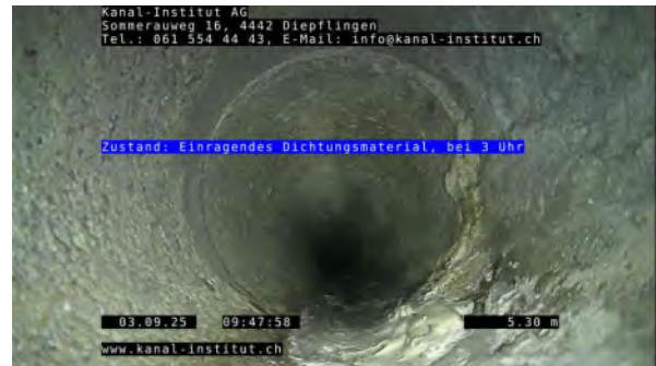
2, 00:07:28, 5.30m Einragendes Dichtungsmaterial, bei 3 Uhr
