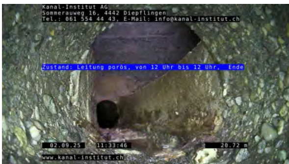
21, 00:10:45, 20.70m Leitung porös, von 12 Uhr bis 12 Uhr, Ende
