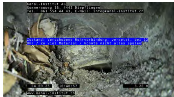
10, 00:00:46, 3.20m Verschobene Rohrverbindung, versetzt, bei 12 Uhr / Zu viel Material / konnte nicht alles spülen
