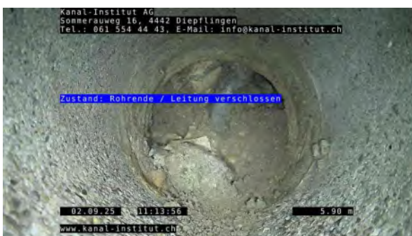
5, 00:02:25, 5.90m Rohrende / Leitung verschlossen
