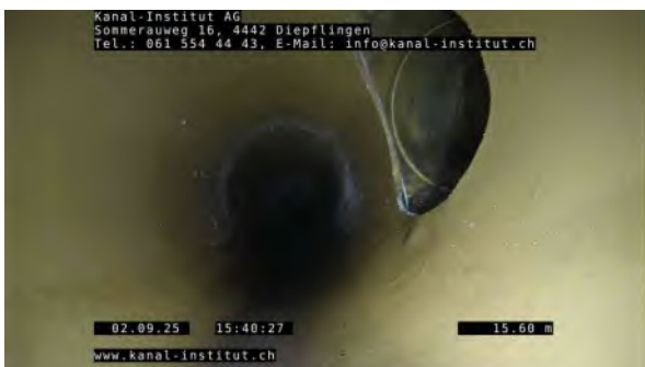
5, 00:03:45, 15.60m Anschluss mit Formstück, offen, bei 2 Uhr
