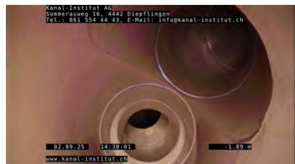
4, 00:02:08, 3.70m Anschluss mit Formstück, offen, bei 2 Uhr
