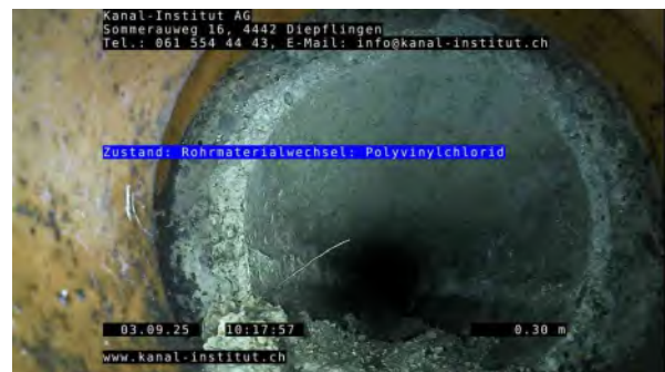
4, 00:04:07, 0.30m Rohrmaterialwechsel: Polyvinylchlorid
