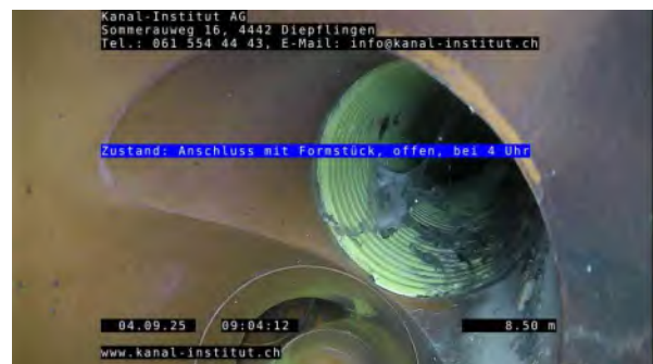
6, 00:10:08, 8.50m Anschluss mit Formstück, offen, bei 4 Uhr
