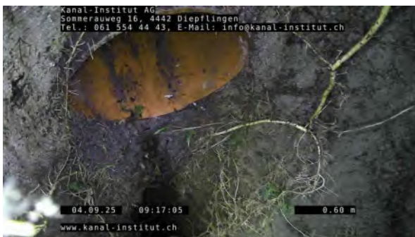
3, 00:01:25, 0.60m Anschluss mit Formstück, offen, bei 5 Uhr
