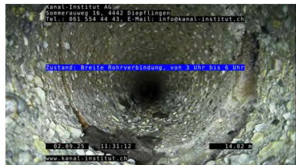
16, 00:08:36, 14.00m Breite Rohrverbindung, von 3 Uhr bis 6 Uhr
