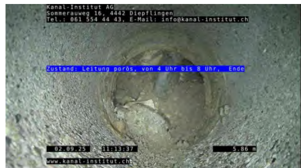
4, 00:02:14, 5.85m Leitung porös, von 4 Uhr bis 8 Uhr, Ende
