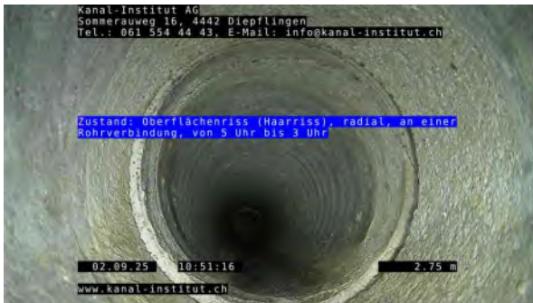
7, 00:02:45, 2.75m Oberflächenriss (Haarriss), radial, an einer Rohrverbindung, von 5 Uhr bis 3 Uhr
