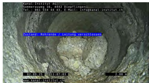
6, 00:02:24, 2.00m Rohrende / Leitung verschlossen
