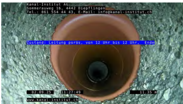
9, 00:06:21, 11.35m Leitung porös, von 12 Uhr bis 12 Uhr, Ende
