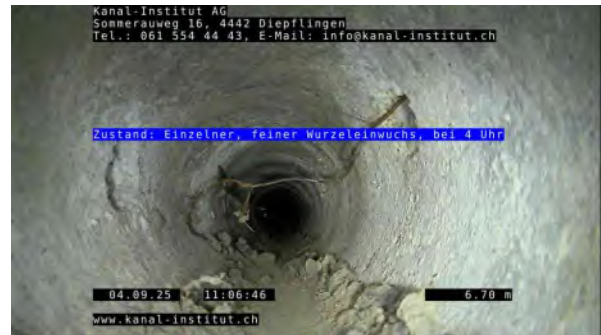
8, 00:01:14, 6.70m Einzeler, feiner Wurzeleinwuchs, bei 4 Uhr
