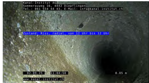
2, 00:00:46, 0.05m Riss, radial, von 12 Uhr bis 12 Uhr
