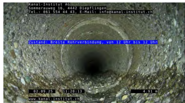
4, 00:02:28, 4.90m Breite Rohrverbindung, von 12 Uhr bis 12 Uhr
