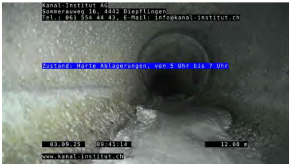
7, 00:03:23, 12.00m Harte Ablagerungen, von 5 Uhr bis 7 Uhr
