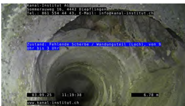
5, 00:03:00, 6.80m Fehlende Scherbe / Wandungsteil (Loch), von 9 Uhr bis 3 Uhr
