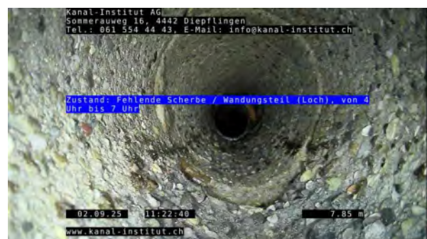
6, 00:03:49, 7.85m Fehlende Scherbe / Wandungsteil (Loch), von 4 Uhr bis 7 Uhr
