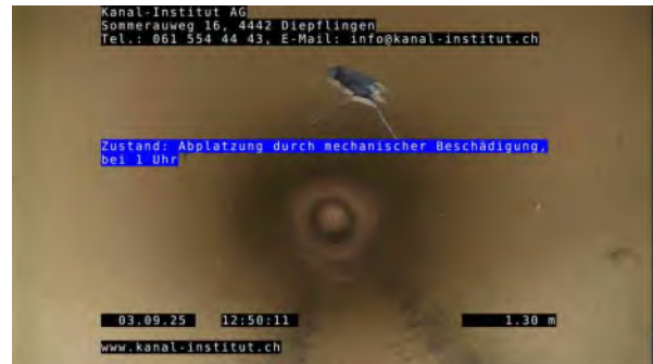
2, 00:01:36, 1.30m Abplatzung durch mechanischer Beschädigung, bei 1 Uhr
