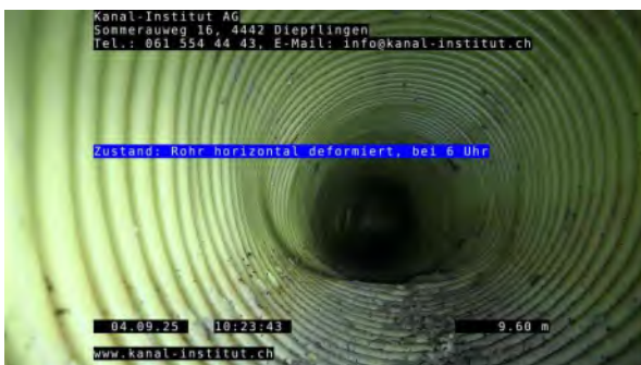
5, 00:03:11, 9.60m Rohr horizontal deformiert, bei 6 Uhr
