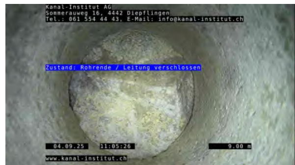
10, 00:00:13, 9.00m Rohrende / Leitung verschlossen
