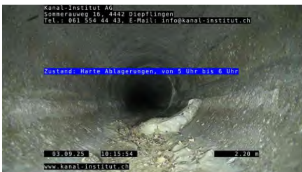
5, 00:02:56, 2.20m Harte Ablagerungen, von 5 Uhr bis 6 Uhr
