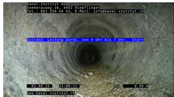
4, 00:01:42, 1.00m Leitung porös, von 5 Uhr bis 7 Uhr, Start
