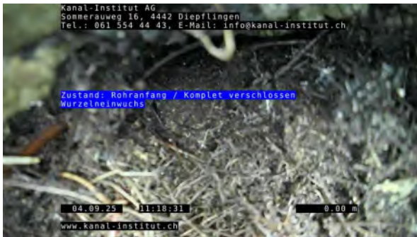
1, 00:00:07, 0.00m Rohranfang / Komplet verschlossen Wurzeleinwuchs
