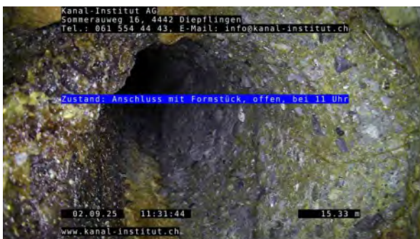
17, 00:08:58, 15.35m Anschluss mit Formstück, offen, bei 11 Uhr
