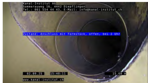
4, 00:03:45, 15.60m Anschluss mit Formstück, offen, bei 2 Uhr
