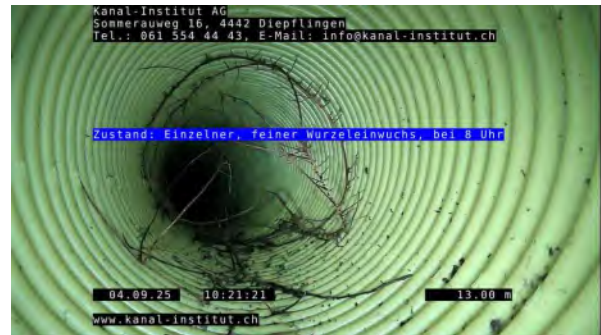
8, 00:01:31, 13.00m Einzeln, feiner Wurzeleinwuchs, bei 8 Uhr
