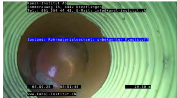
20, 00:01:20, 29.60m Rohrmaterialwechsel: unbekannter Kunststoff
