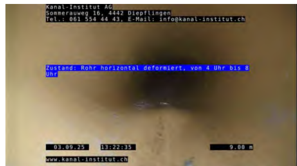
4, 00:01:25, 9.00m Rohr horizontal deformiert, von 4 Uhr bis 8 Uhr
