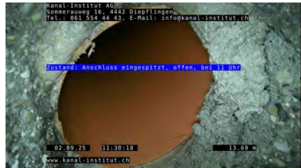
14, 00:07:57, 13.70m Anschluss eingespitzt, offen, bei 11 Uhr
