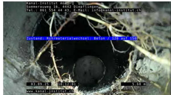
8, 00:00:57, 5.60m Rohrmaterialwechsel: Beton / 120 auf 150
