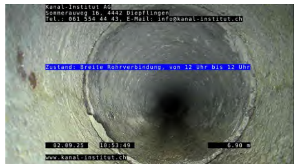
10, 00:04:55, 6.90m Breite Rohrverbindung, von 12 Uhr bis 12 Uhr
