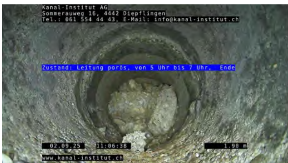
5, 00:02:06, 1.90m Leitung porös, von 5 Uhr bis 7 Uhr, Ende
