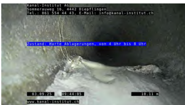
5, 00:05:16, 10.10m Harte Ablagerungen, von 4 Uhr bis 8 Uhr
