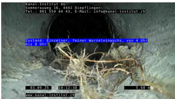
9, 00:01:15, 5.60m Einzelner, feiner Wurzeleinwuchs, von 4 Uhr bis 8 Uhr
