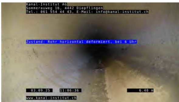
3, 00:02:09, 6.40m Rohr horizontal deformiert, bei 6 Uhr
