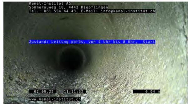
2, 00:00:28, 0.05m Leitung porös, von 4 Uhr bis 8 Uhr, Start
