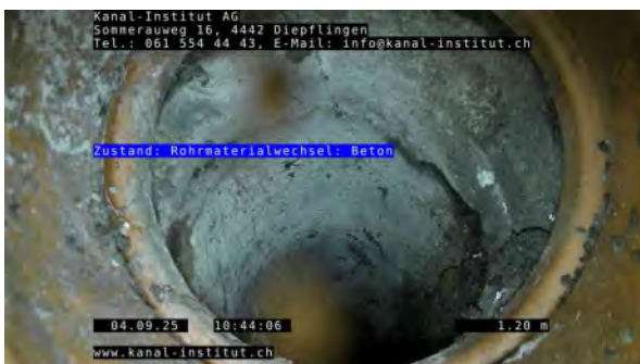
5, 00:02:43, 1.20m Rohrmaterialwechsel: Beton
