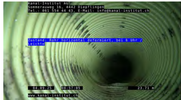
14, 00:04:31, 23.70m Rohr horizontal deformiert, bei 6 Uhr / Leichte
