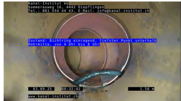
2, 00:01:49, 1.50m Dichtring einragend, tiefster Punkt unterhalb Rohrmittle, von 4 Uhr bis 8 Uhr
