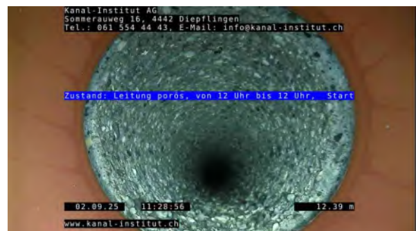
12, 00:07:04, 12.40m Leitung porös, von 12 Uhr bis 12 Uhr, Start
