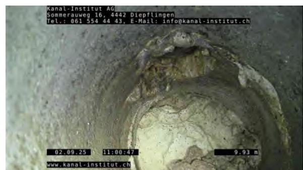
12, 00:05:52, 9.95m Anschluss mit Formstück, offen, bei 12 Uhr
