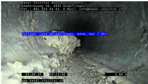
7, 00:01:46, 4.80m Lose Ablagerungen, Sand, bei 7 Uhr
