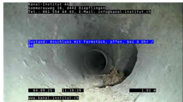
4, 00:04:06, 1.00m Anschluss mit Formstück, offen, bei 4 Uhr / BA
