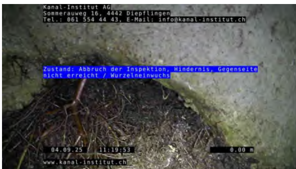
3, 00:00:41, 0.00m Abbruch der Inspektion, Hindernis, Gegenseite nicht erreicht / Wurzeleinwuchs
