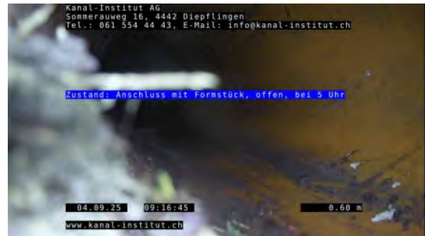
2, 00:01:25, 0.60m Anschluss mit Formstück, offen, bei 5 Uhr
