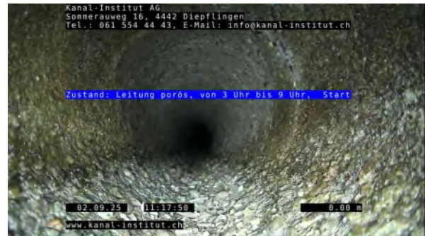
2, 00:00:24, 0.00m Leitung porös, von 3 Uhr bis 9 Uhr, Start
