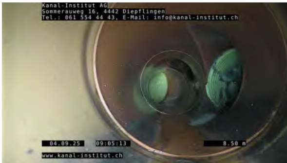
7, 00:10:08, 8.50m Anschluss mit Formstück, offen, bei 4 Uhr
