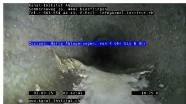
6, 00:04:14, 10.75m Harte Ablagerungen, von 4 Uhr bis 6 Uhr
