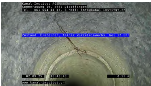
3, 00:00:51, 0.55m Einzelner, feiner Wurzeleinwuchs, bei 12 Uhr
