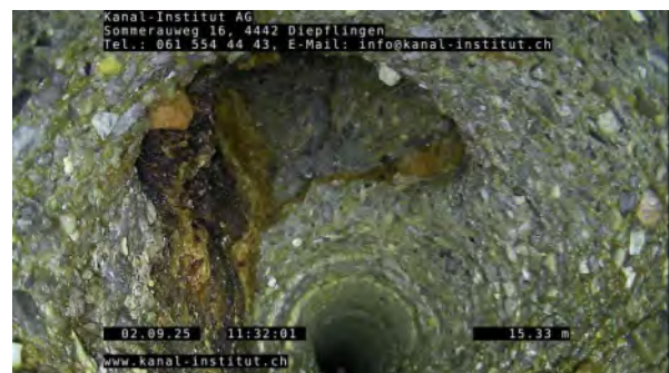
18, 00:08:58, 15.35m Anschluss mit Formstück, offen, bei 11 Uhr
