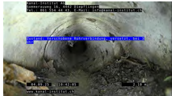
8, 00:01:33, 2.10m Verschobene Rohrverbindung, versetzt, bei 3 Uhr
