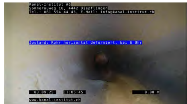
4, 00:01:34, 8.00m Rohr horizontal deformiert, bei 6 Uhr
