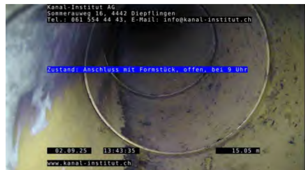
4, 00:02:58, 15.05m Anschluss mit Formstück, offen, bei 9 Uhr
