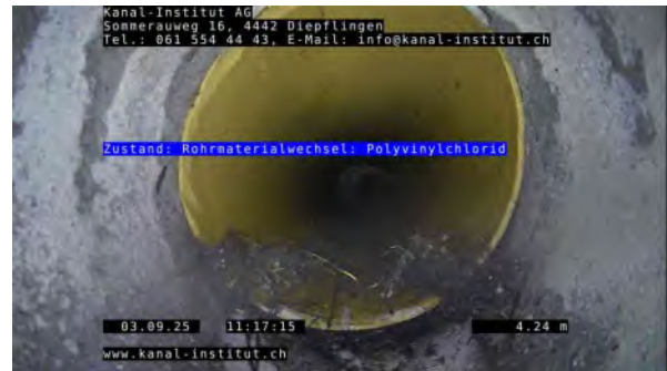
2, 00:01:02, 4.25m Rohrmaterialwechsel: Polyvinylchlorid
