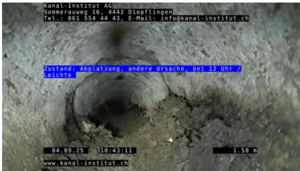
7, 00:02:05, 1.50m Abplatzung, andere Ursache, bei 12 Uhr / Leichte
