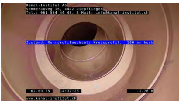
5, 00:01:52, 3.85m Rohrprofilwechsel: Kreisprofil, 100 mm hoch
