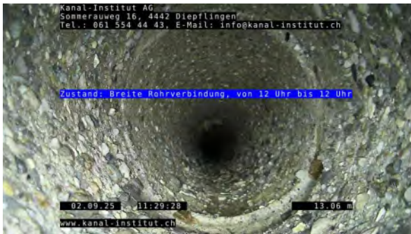
13, 00:07:27, 13.05m Breite Rohrverbindung, von 12 Uhr bis 12 Uhr
