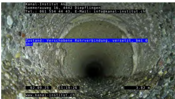
3, 00:01:50, 3.80m Verschobene Rohrverbindung, versetzt, bei 6 Uhr
