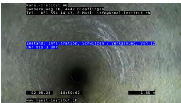
5, 00:01:52, 1.85m Infiltration, Schwitzen / Veralkung, von 12 Uhr bis 3 Uhr
