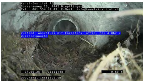
3, 00:04:51, 0.60m Anschluss mit Formstück, offen, bei 4 Uhr / Wurzeleinwuchs
