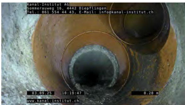
3, 00:04:49, 0.20m Anschluss mit Formstück, offen, bei 2 Uhr
